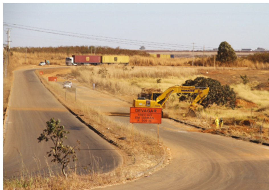
Máquinas da Goinfra, há alguns dias, já realiza trabalhos de limpeza da extensão da via e faz etapa de mobilização
